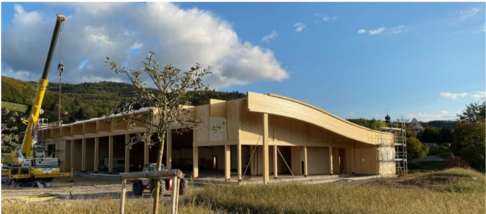
Ein Supermarkt ganz aus Holz entstand in Sölden im Breisgau. Quelle: Beckesepp
